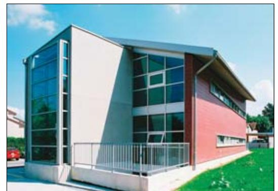
Le deuxième volume, bâti sur une base identique, figure une sorte de dilatation du premier sur la petite place et offre un vis-à-vis plus sensible au logement. Bordé de plaques en fibrociment de couleur chaude, il est percé de fines ouvertures horizontales, protégées par un large avant-toit.
