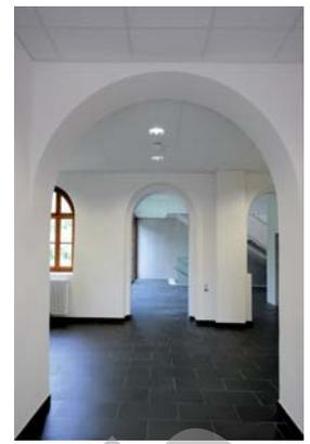
A l'intérieur, les sols des classes sont revêtus de linoléum et de mosaïques dans les sanitaires. Les murs des classes restent en béton apparent (coffrages type 4) tandis que des faux-plafonds phoniques en plaques de plâtre perforées assurent le confort acoustique requis. L'école est dotée d'interrupteurs couplés avec des détecteurs de présence et les stores extérieurs sont motorisés.
