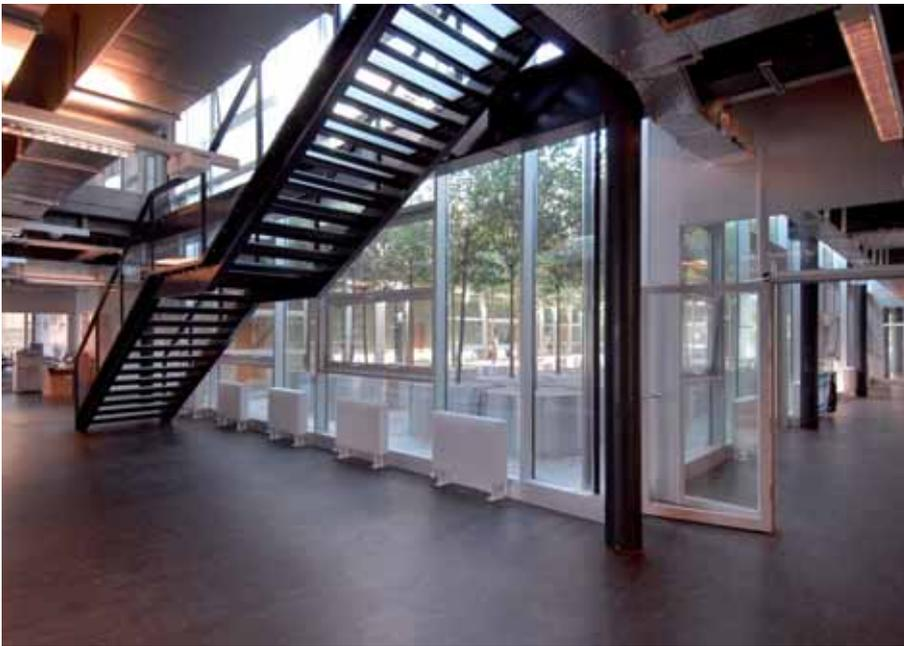
La façade offre un rythme régulier basé sur la trame de 7,20 m du plan directeur, multiple du module de 1,20 m. Le maître de l'ouvrage désirant des fenêtres à guillemettes, il a été décidé de les monter en usine. La façade a donc été posée par éléments de 3.60 par 9.60 m de haut avec tous les éléments y compris les verres montés.
