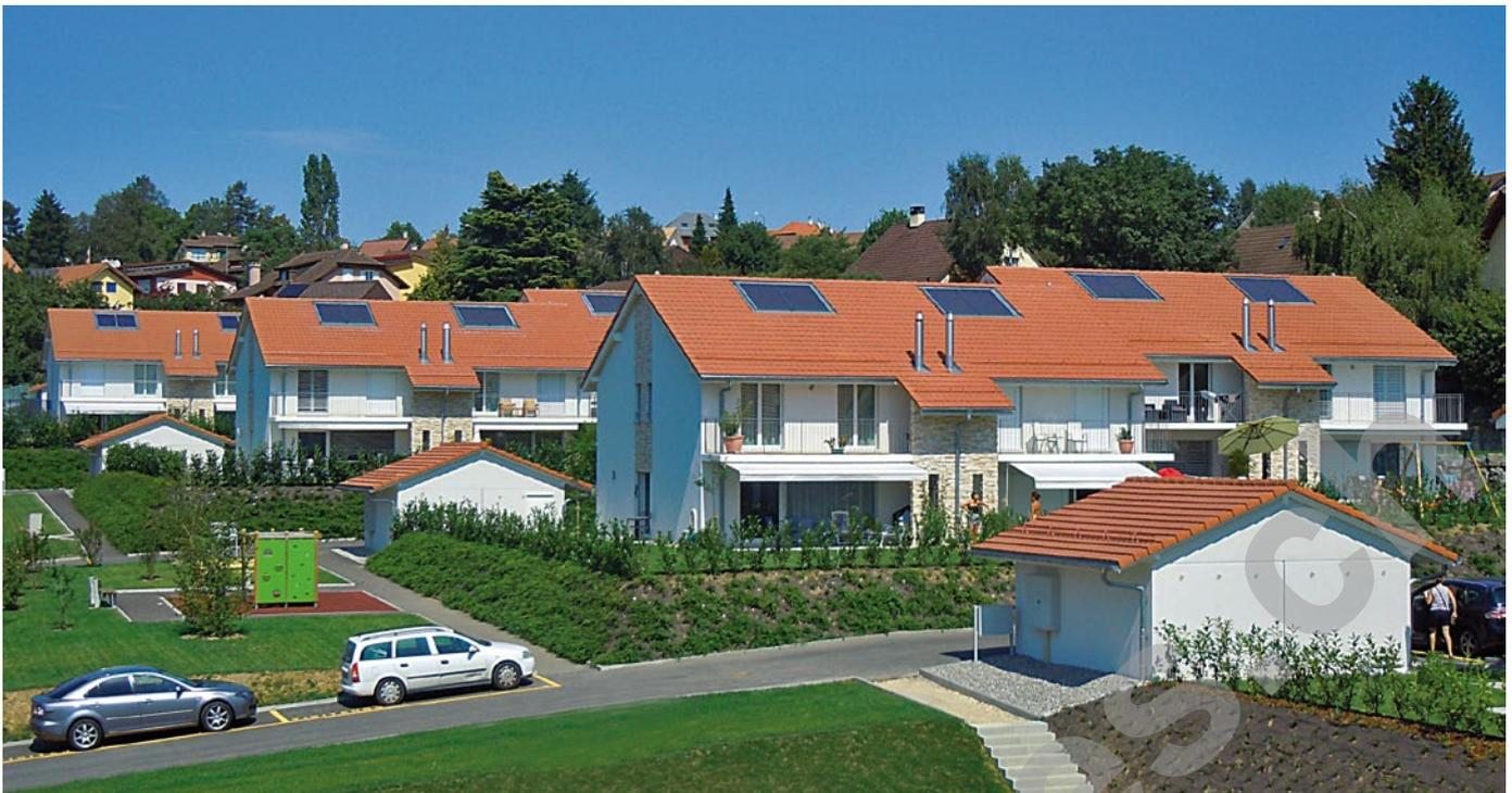
Ces mesures se complètent par une installation de ventilation douce, à double flux et récupération de chaleur, ainsi que par des panneaux solaires disposés en toiture et capable de fournir environ 65% de l'énergie nécessaire au chauffage de l'eau chaude sanitaire. Le solde est assuré par relais automatique de la chaudière à gaz. Cette dernière est alimentée en énergie thermique par des puits forés équipés d'une sonde géothermique.
