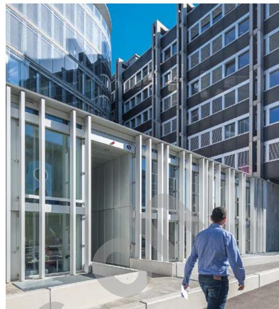
crèche). La matérialisation de l'émergence est composée d'une double peau composite en verre et métal répondant aux normes hautement performantes sur le plan énergétique.
