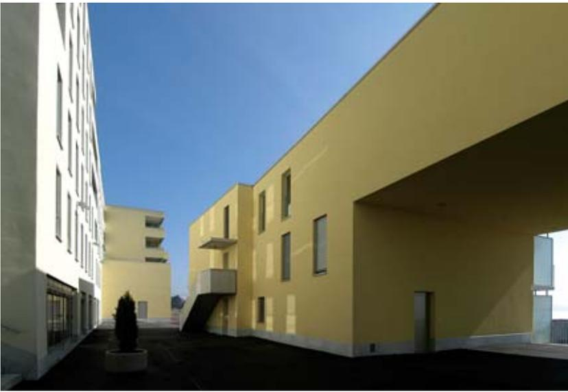
Les immeubles répondent à des normes de qualité standard. Les structures en béton armé sont revêtues par l'isolation périphérique sur laquelle on applique un crépi synthétique teinté dans la masse. L'enveloppe est complétée par des vitrages isolants à cadres en PVC.
