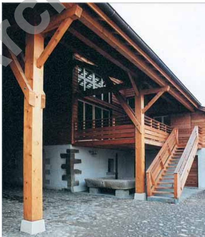
Détail de la structure bois
