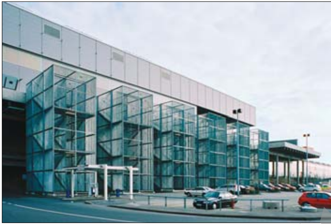
Escaliers de secours côté Aéroport
