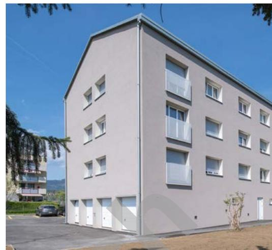
**RÉALISATION** > Cette construction représentative des années septante s'articule sur des murs porteurs en maçonnerie. La nouvelle isolation périphérique de 18 centimètres est recouverte d'un crépi sur tout le pourtour du bâtiment.
