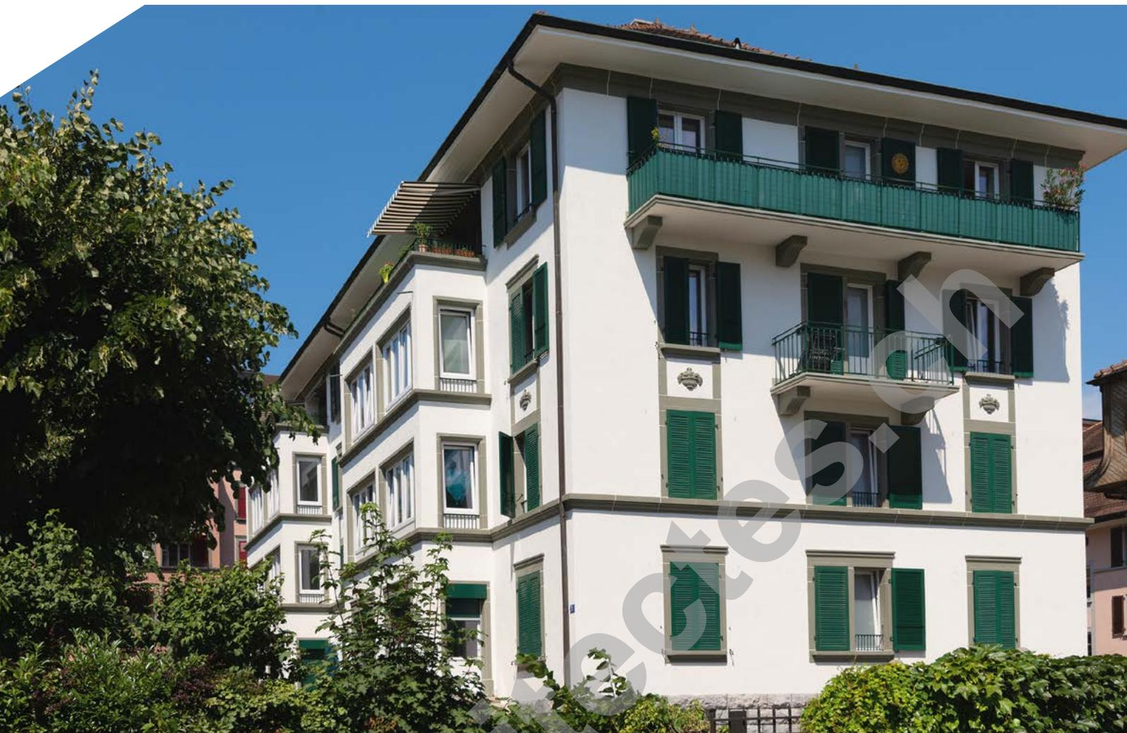
**RÉALISATION** > Il s'agissait donc de reprendre les façades pour traiter les fissures et lutter contre la carbonatation. Le recensement architectural vaudois a classé en note 4 l'ensemble formé par les deux bâtiments – notamment pour les moulures qu'ils présentent – ce qui interdisait toute mise en place d'isolation périphérique.
