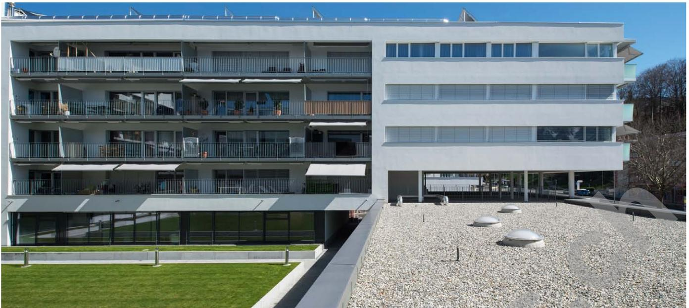
isolation périphérique de 35 centimètres et un triple vitrage pour les fenêtres. Toutes ces mesures font de l'ensemble du complexe, une construction labellisée Minergie-P, un standard énergétique élevé.
