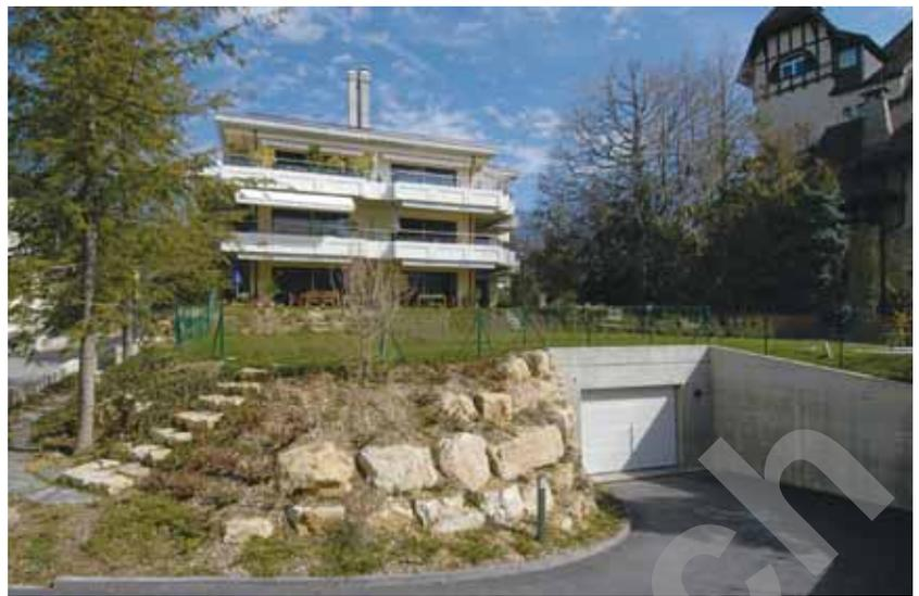
éclairé par des fenêtres Velux et réservant une mezzanine qui donne sur le séjour. Sur le plan constructif, le bâtiment est conçu et mis en œuvre de façon classique, et à l'aide d'éléments préfabriqués, notamment pour l'exécution des parapets de balcons.
