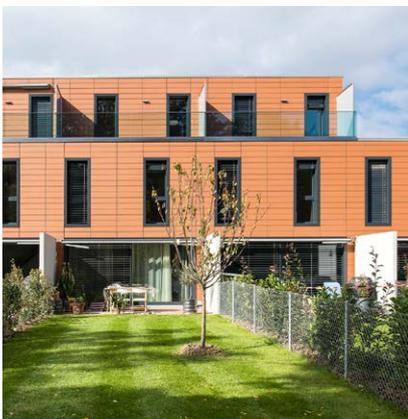
La structure est mixte en béton armé et les façades longitudinales sont préfabriquées en ossature bois et terre cuite.
