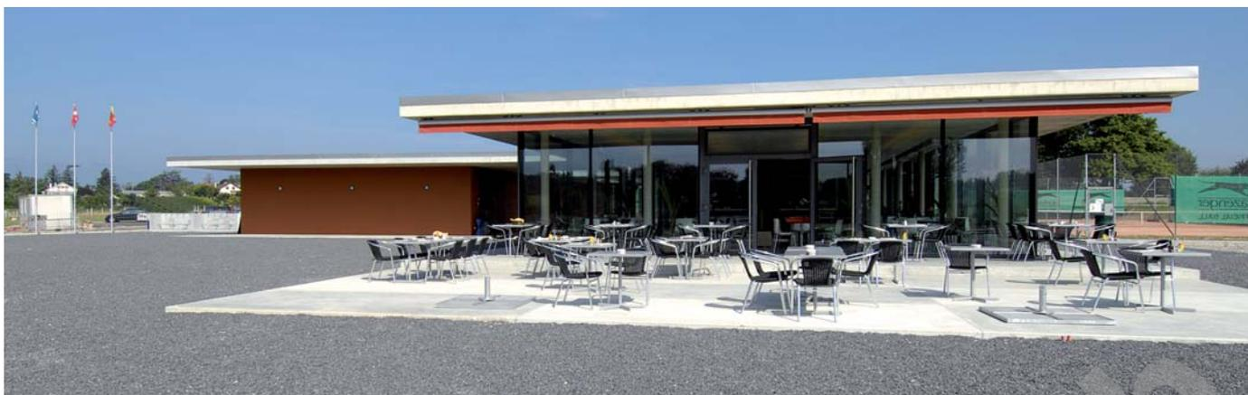
Compte tenu de sa fonction particulière, le bâtiment des vestiaires a une façade sans percement, l'éclairage naturel étant garanti par des jours zénithaux en toiture. A contrario, le restaurant a une façade totalement vitrée, créant ainsi une continuité entre l'intérieur et l'extérieur. Un large avant-toit formant couvert relie les deux bâtiments, servant à la fois de protection contre les intempéries et de brise-soleil.
