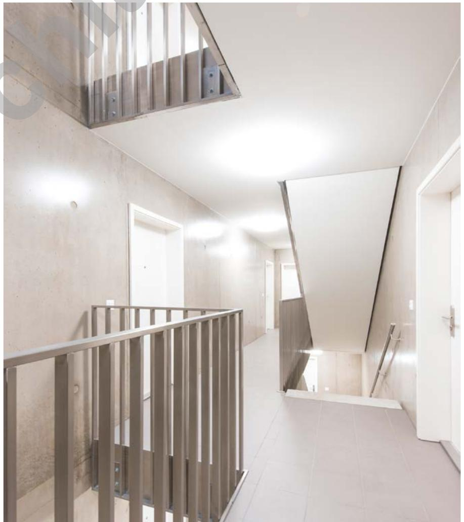
À l'intérieur, les matériaux sont simples, bruts et de qualité : murs en béton brut et carrelage au sol dans la cage de distribution, pour une grande durabilité. Fenêtres bois-métal et parquet dans les logements.
