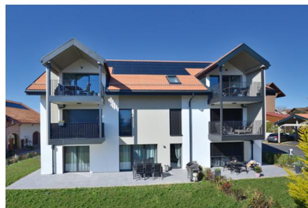
du bâtiment. Une pompe à chaleur air/eau, des panneaux thermiques et photovoltaïques, ainsi que des triples vitrages permettent de répondre aux exigences du label. Cette certification a permis au Maître d'ouvrage d'augmenter de 5% la surface des logements, créant ainsi des volumes de pièces confortables.
