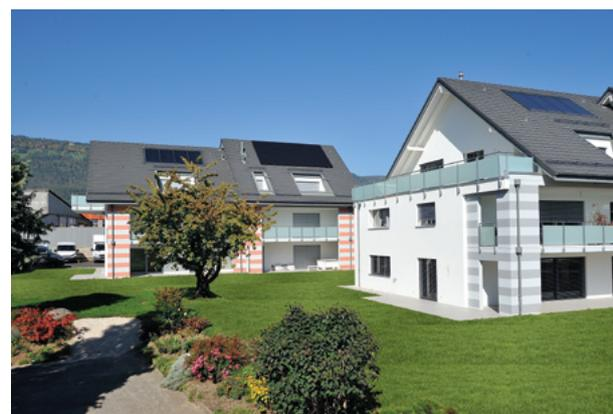
**RÉALISATION** > Le terrain ayant une capacité limitée d'infiltration des eaux, un concept d'étanchéité avec cuve blanche a été choisi. Dalles en béton, murs porteurs mixtes en béton et brique terre cuite, laine minérale pour l'isolation des façades, la structure est conforme aux pratiques constructives habituelles. Une charpente en bois avec isolation en laine de bois insufflée assure le confort intérieur tout en conférant un charme particulier aux espaces aménagés dans les combles.
