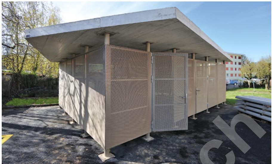
**RÉALISATION** > Les anciens balcons, situés dans le volume de l'édifice, ont été détruits et remplacés par des structures en béton reposant sur des piliers et accrochées à la façade. Tous les appartements bénéficient ainsi d'un espace extérieur, sans que la façade d'origine n'ait subi de lourdes transformations. Une isolation périphérique en béton cellulaire a été ajoutée, et le revêtement en résine permet d'intégrer harmonieusement les nouveaux éléments.
