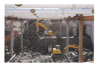
surpressions d'eau. Son niveau est situé à environ 17 m sous le terrain naturel. La partie centrale du radier a servi, en phase chantier, d'appui à des butons périphériques en béton armé, afin de bloquer les déplacements de la paroi moulée en fond de fouille.
