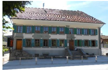
Le bâtiment avant transformation
